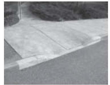
Perpendicular curb ramp.
